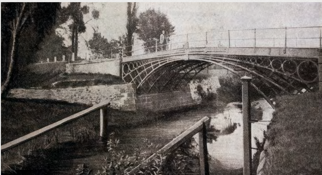
Most żelazny nad Strzegomką w Łażanach, ok. 1900.
